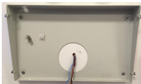
Рисунок 9 – Монтаж основания Панели
